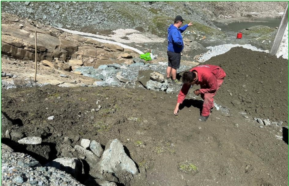
Bild 13: Händisches Einbringen der aus den zukünftig überschütteten Flächen geborgenen Vegetationsteile (06.08.2024).
