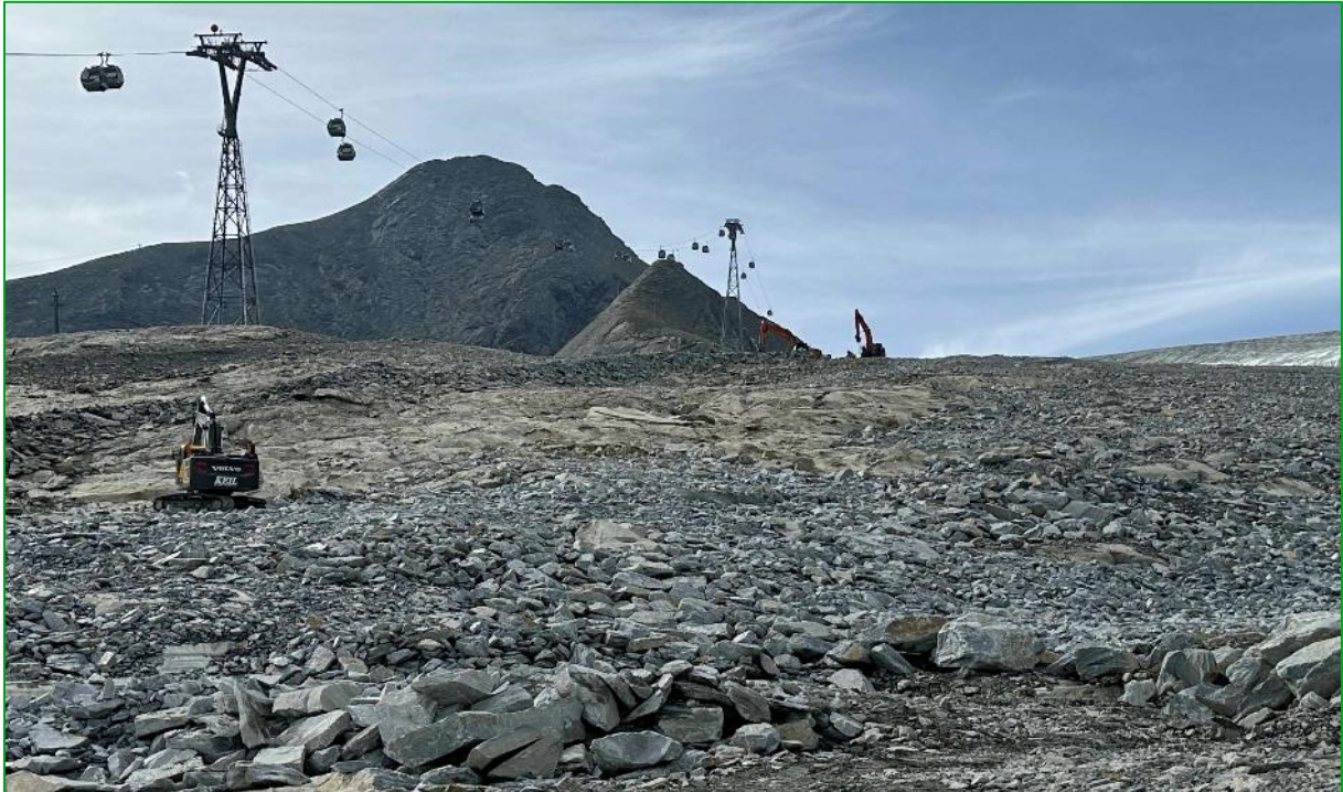
Bild 29: Gut gelungene Gestaltungen im unteren Teil der Geländeanpassungen der Kitzlifte mit strukturierten Felschüttungen, Einbindung größerer Felsbrocken und der Natur nachempfundenen Anschlüssen an die gletschergeschliffenen Felsrücken (22.08.2024).
