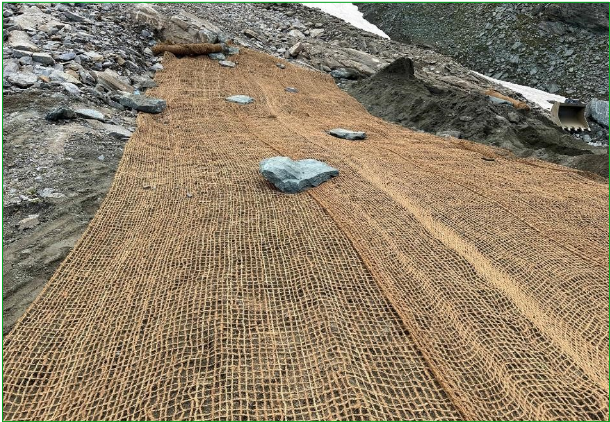
Bild 17: Abgerolltes und mit Steinen fixiertes Kokosgewebe, das die Begrünungsmaßnahmen abschließt und sichert (06.08.2024).
