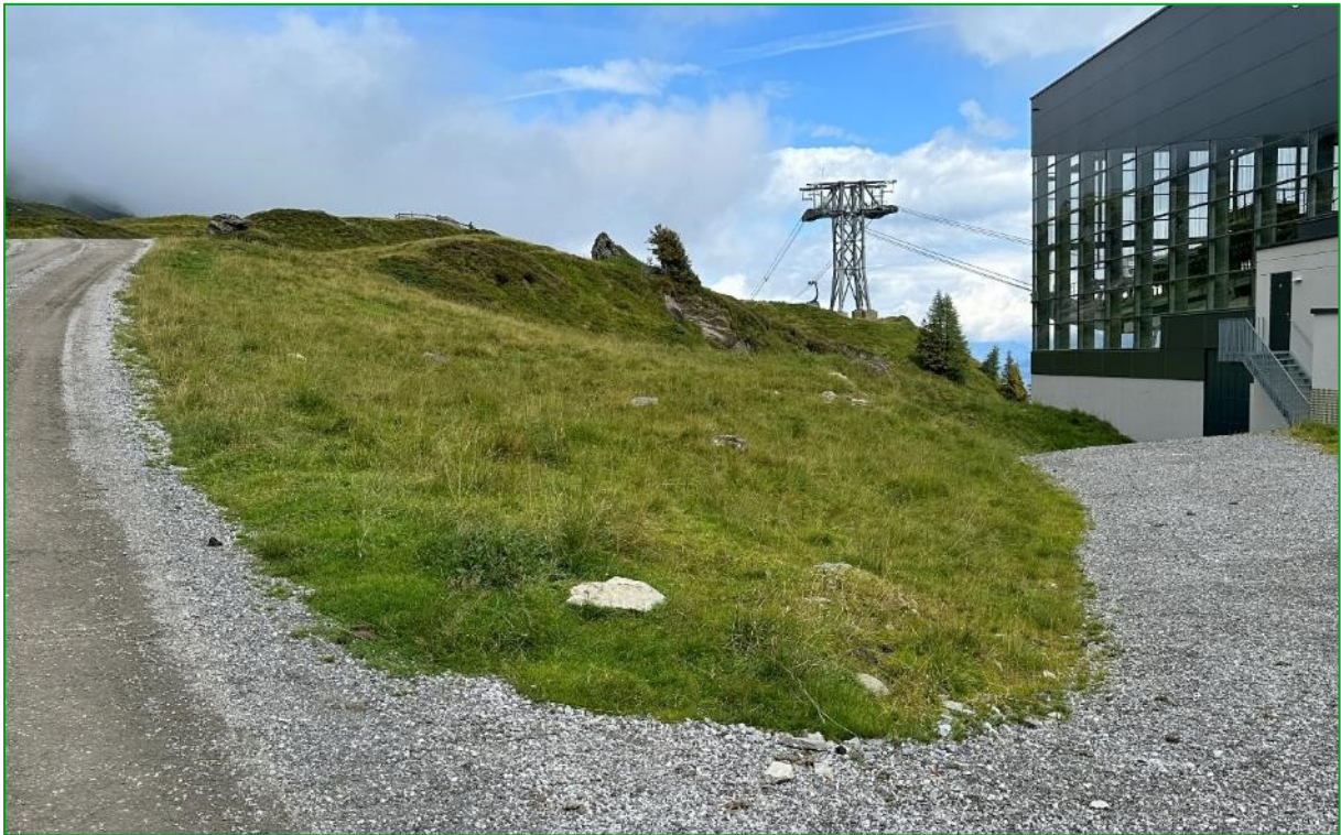
Bild 3: Dort, wo noch vor wenigen Jahren die Baubereiche der Bergstation der 3K K-onnection waren, bedecken heute alpine Rasen die Eingriffsflächen, diese sind nicht von den Weiderasen der Umgebung zu unterscheiden (06.08.2024).
