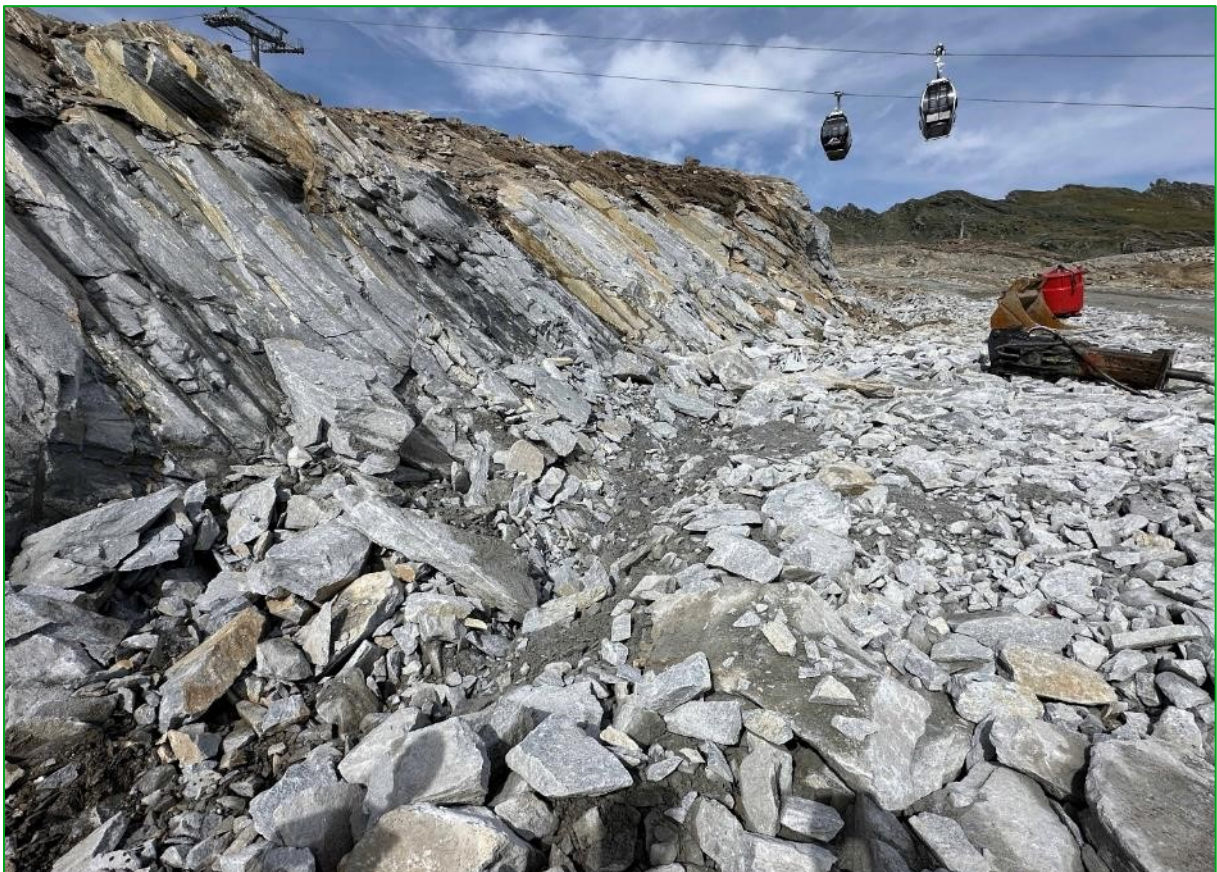
Bild 30: Fertig gestellte Böschung des verbreiterten Schmiedingerweges mit guter Strukturierung (22.08.2024).
