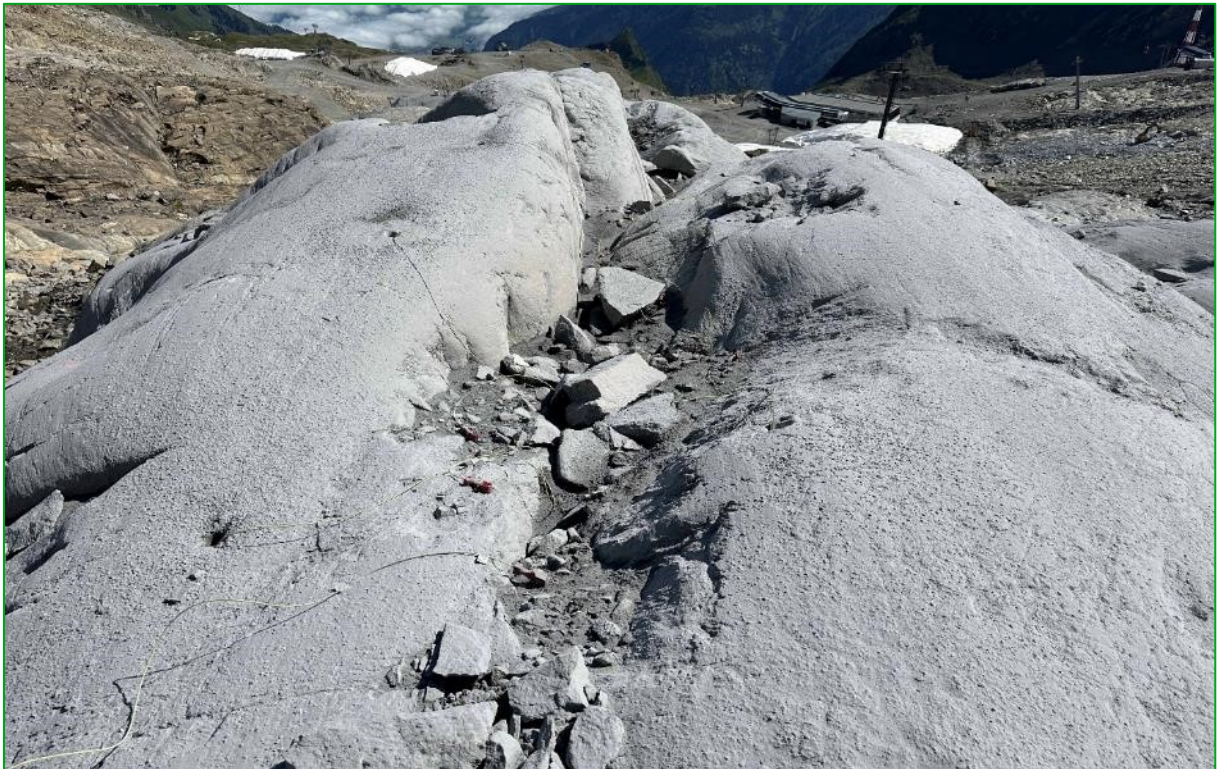
Bild 33: Vorbereitung der Sprengungen im Bereich der Maurerpiste (13.08.2024).
