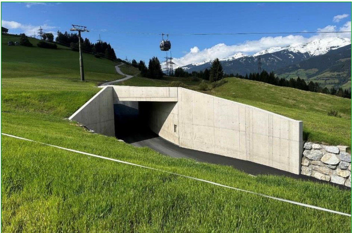
Bild 48: Die weitgehend fertig gestellte Schipistenunterführung Maiskogel (19.09.2024).
