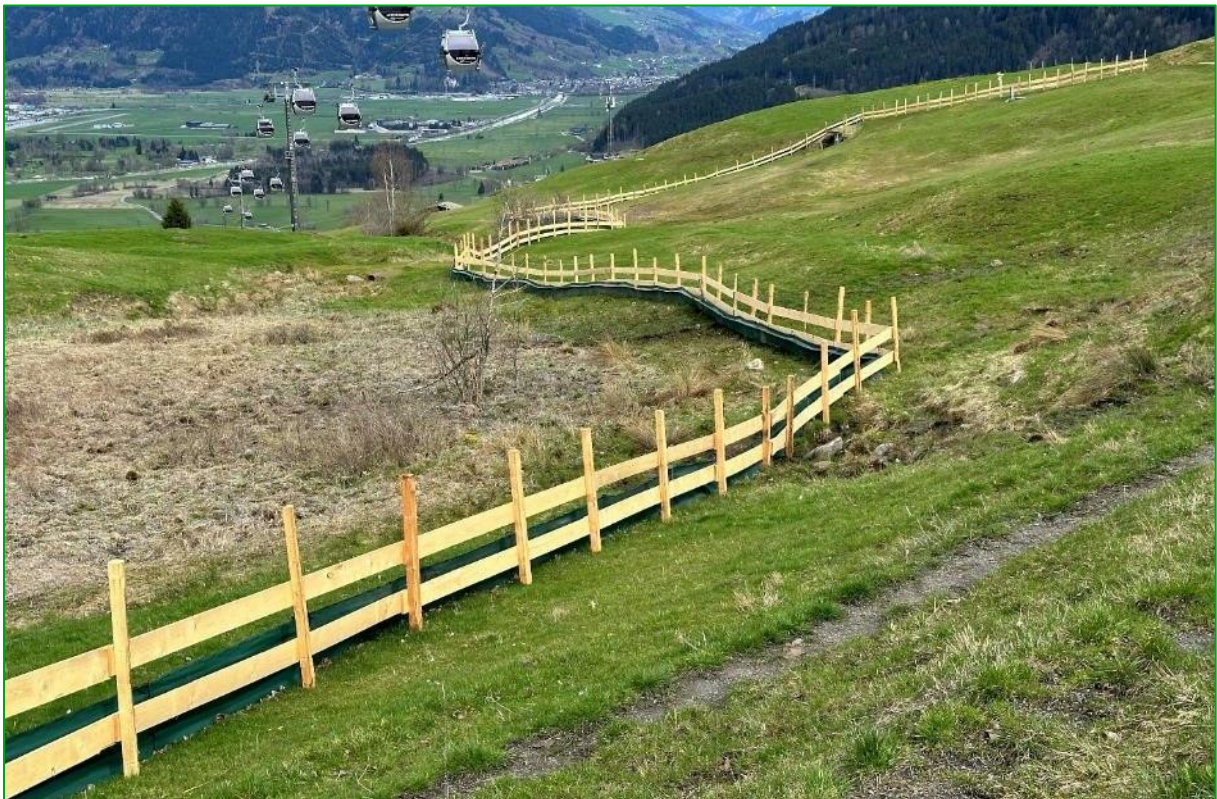
Bild 42: Der Bauzaun stellt in Kombination mit dem Amphibienschutzzaun einen äußerst effektiven Schutz für das an die Baustelle angrenzende Feuchtgebiet dar (04.04.2024).
