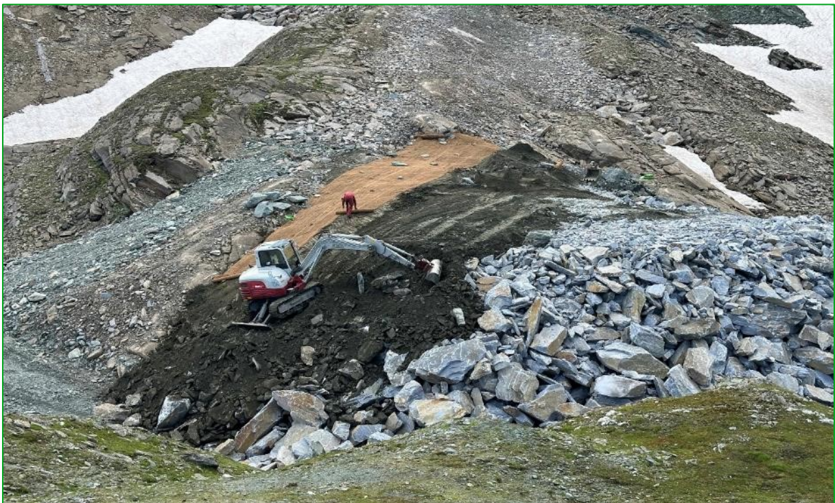
Bild 18: Es wurde festgelegt, dass auch Bereiche begrünt werden (im Bild links neben den eigentlichen Flächen der Pistenanpassung), um ein noch besseres Einbinden der Geländeanpassung zu gewährleisten (06.08.2024).
