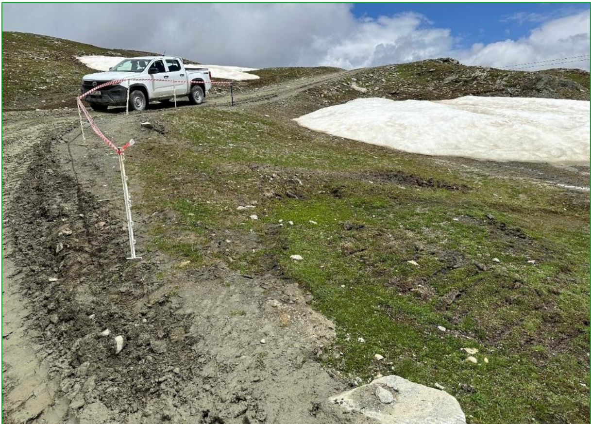
Bild 8: Vor Beginn der Arbeiten an der Rettenwandkompression wurden die Flächen mit vorhandener alpiner Vegetation entsprechend abgezaunt (27.06.2024).
