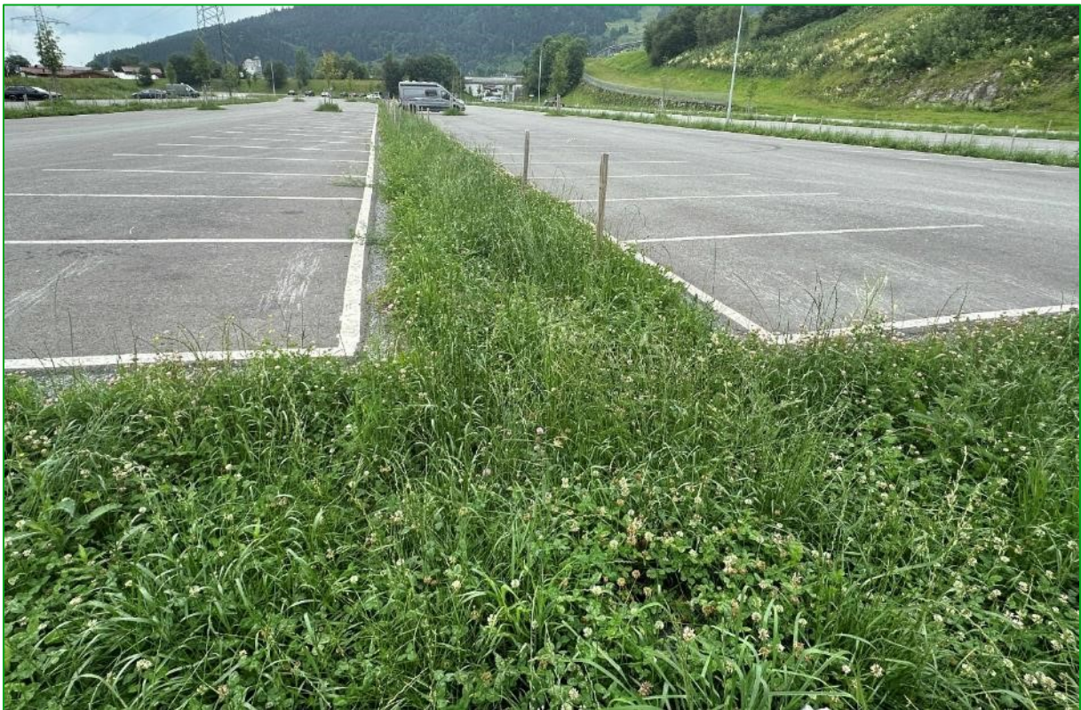
Bild 58: Die die Parkflächen unterbrechenden bzw. gliedernden Sickermulden wiesen auch 2024 durchwegs eine geschlossene Vegetationsdecke auf (27.06.2024).
