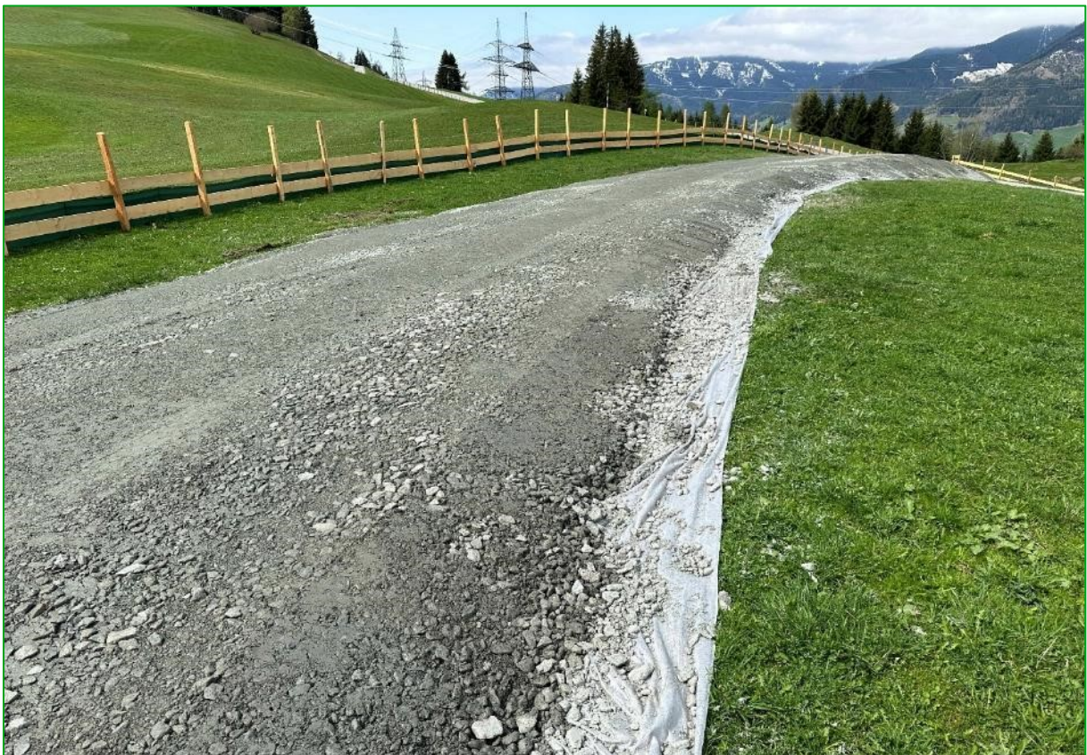
Bild 44: Westteil der Baustraße mit gut erkennbarer Vliesgründung (11.04.2024).
