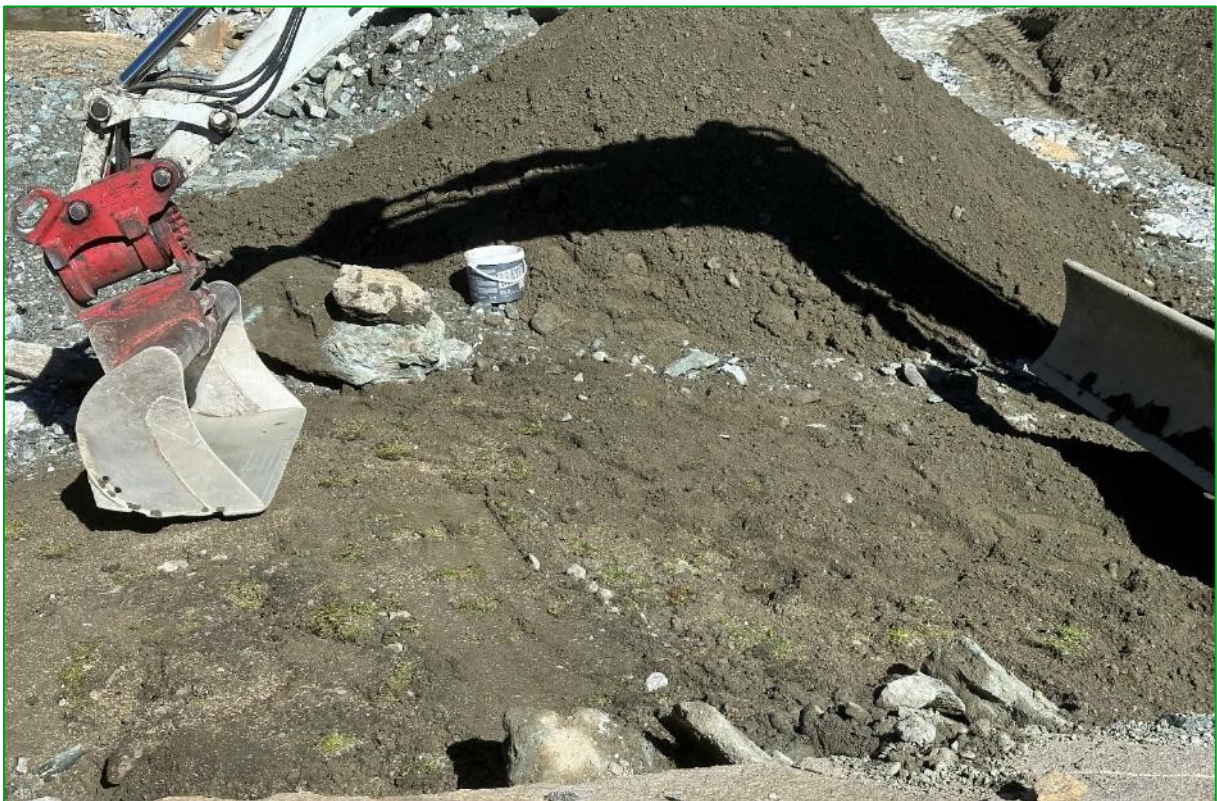
Bild 14: Nach Einbringen der Vegetation, erfolgter Einsaat und Düngung wurde das Planum mit dem Böschungslöffel festgedrückt, wodurch Rasensoden, Saatgut und Düngematerial in den obersten Bodenschichten fixiert wurden (06.08.2024).
