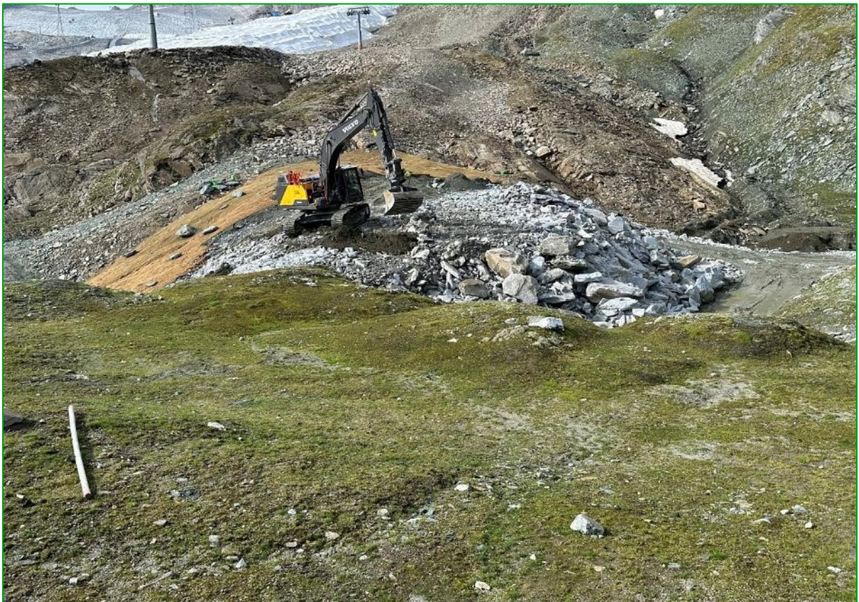
Bild 22: Auf diesem Bild ist bereits erkennbar, wie der ehemalige Tiefpunkt der Rettenwandpiste durch einen der Natur angepassten Geländeriegel, der aufwendig begrünt wird, aufgefüllt wird (22.08.2024).
