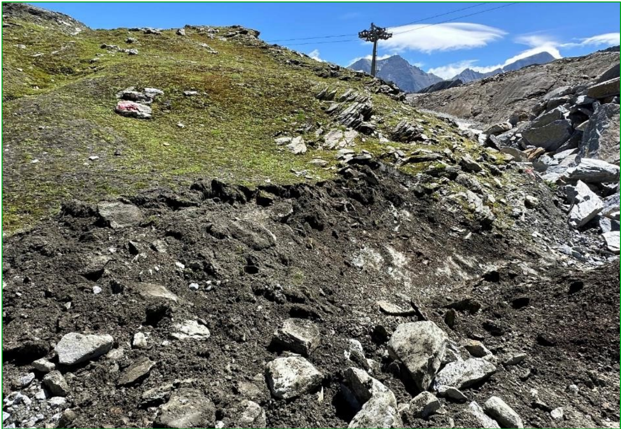
Bild 19: Obwohl die Vegetation äußerst flachgründig und der Oberboden sehr brüchig war, erfolgte eine quantitative Entnahme und Bergung der alpinen Vegetation (06.08.2024).
