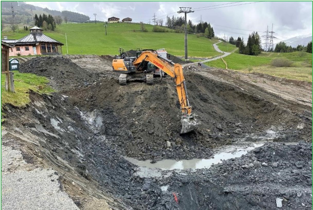
Bild 45: Im Bereich der abgetragenen Asphaltstraße erfolgte der Aushub für die Fundamentierung der Brückenkonstruktion (17.04.2024).
