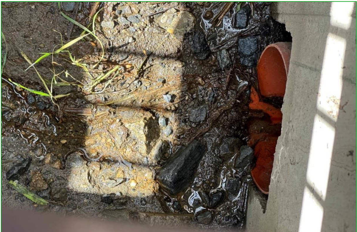
Bild 50: Korrekt nivelliertes Abflussrohr der westlichen Viehsperre, über das Kleintiere den Betontrog verlassen können (19.09.2024).
