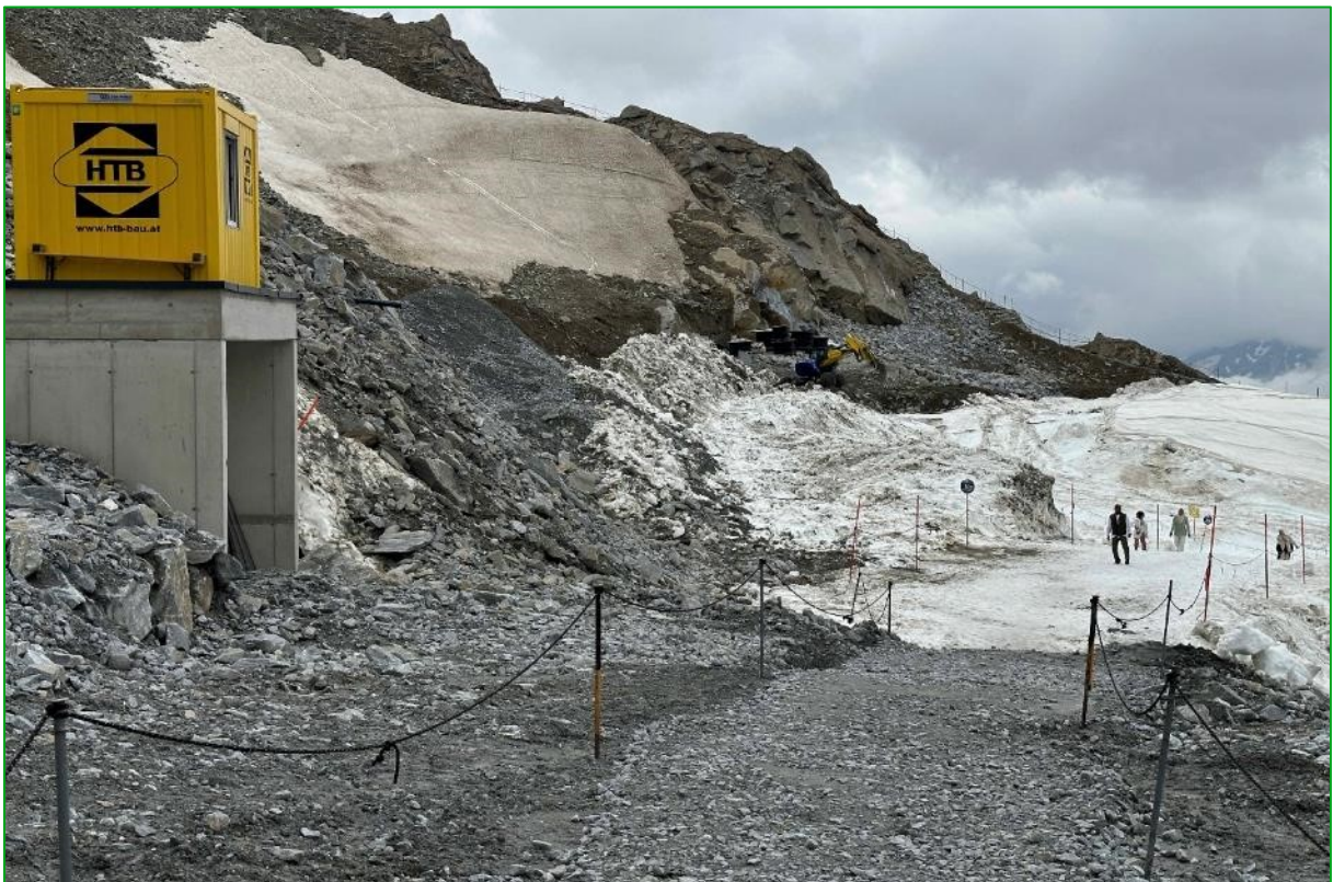
Bild 38: Verlegearbeiten der Schneileitungen in den höchstgelegenen Abschnitten des Schigebietes im Nahbereich der Bergstation vom Gletscherjet 4 (08.07.2024).
