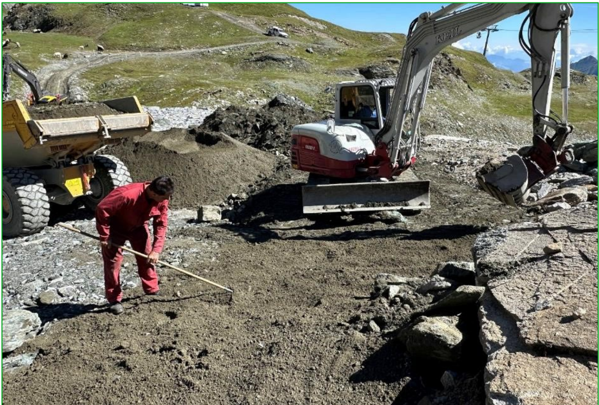
Bild 12: Herstellen eines Oberbodenplanums durch händisches Ausrechen (06.08.2024).
