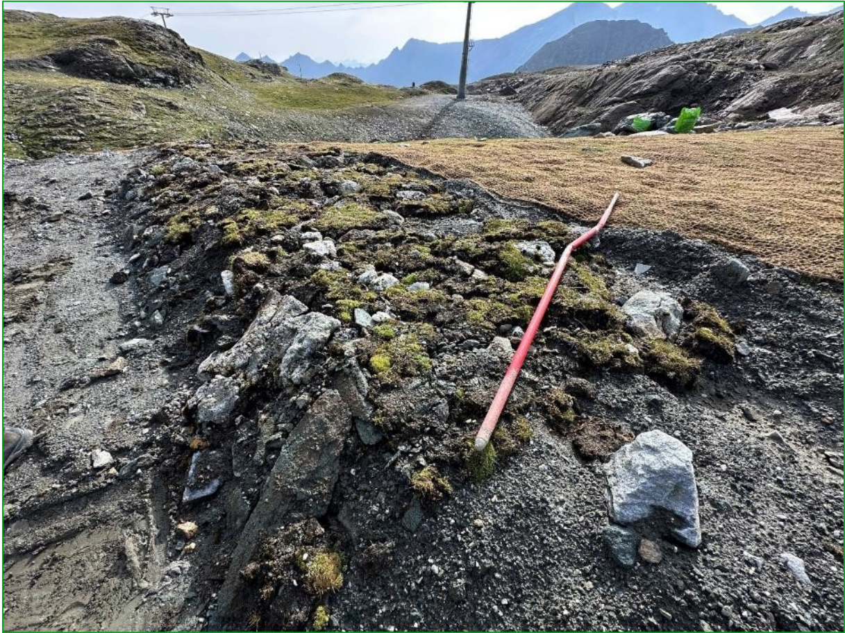
Bild 23: Akribische Zwischenlagerung auch kleinster Rasenstücke für die Wiederverwertung im Rahmen der Begrünungstätigkeit. (22.08.2024).
