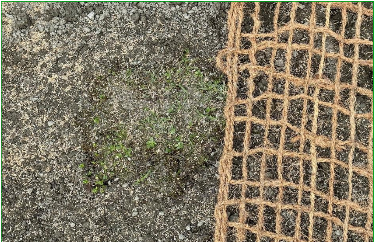
Bild 16: Eingebrachter Rasenziegel, erfolgte Einsaat mit relativ hohen Saatgutstärken und Fixierung der Gestaltungen durch ein Kokosgewebe (06.08.2024).
