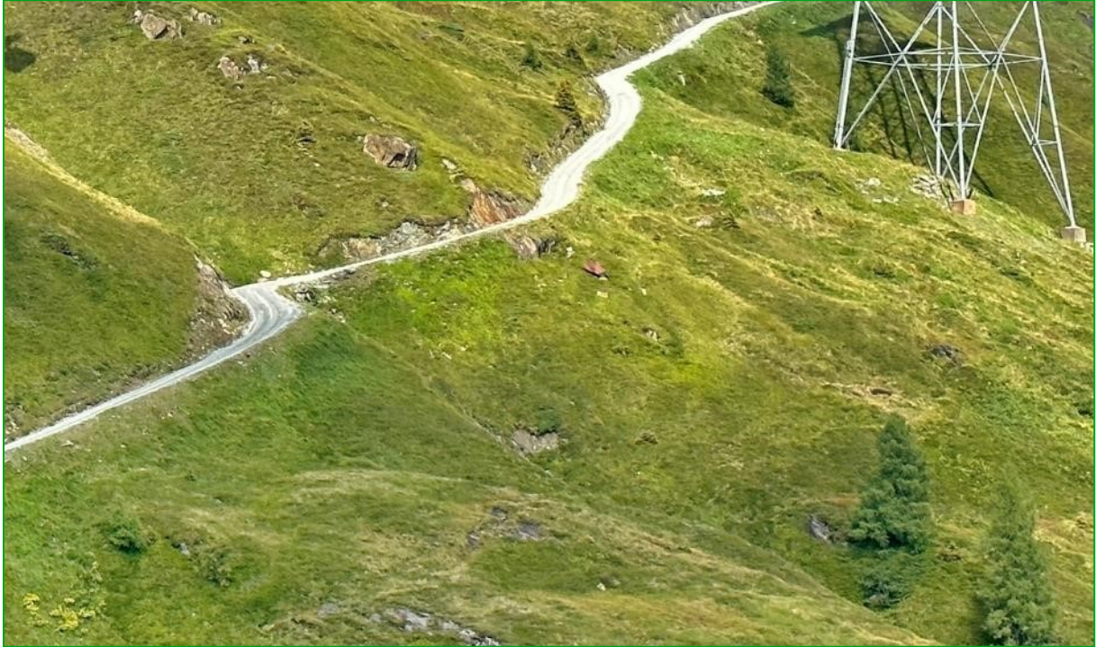
Bild 1: Die vor wenigen Jahren durchgeführten Begrünungen in den Böschungsbereichen des Astenweges und in den Baubereichen der Stützen der 3K K-onnection zeigen keinerlei Ausfälle, die Eingriffsflächen sind von einer quasi natürlichen Vegetation bedeckt (06.08.2024).
