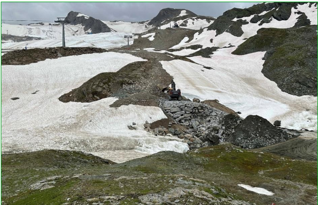
Bild 10: Die Schüttungen im Bereich der Rettenwandkompression beschränkten sich anfangs ausschließlich auf Bereiche, in denen keine Vegetationsdeckung vorlag (08.07.2024).
