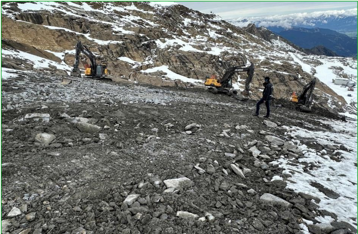
Bild 37: Im Bereich der Maurerpiste wurde vorerst das Felsmaterial eingeebnet, um eine befahrbare Pistenfläche herzustellen, die Gestaltungsarbeiten wurden auf das Jahr 2025 verschoben (01.10.2024).
