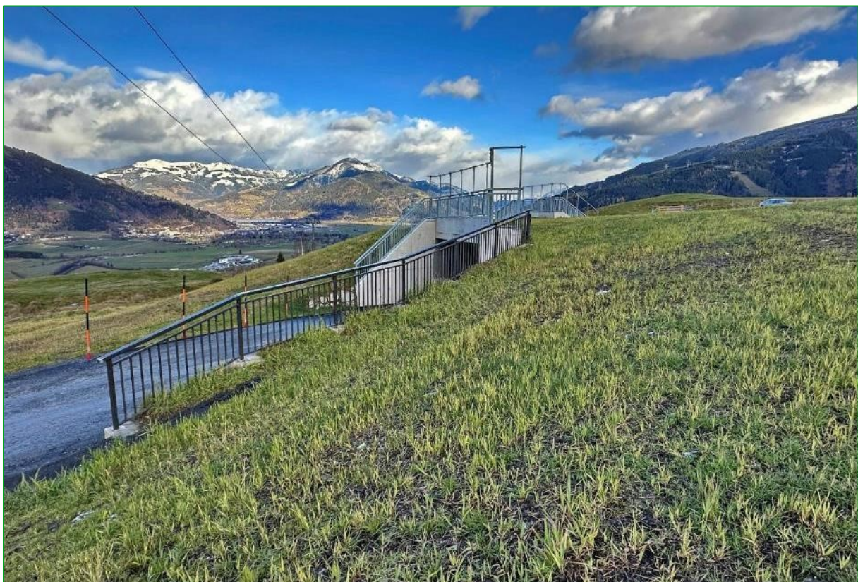
Bild 52: Auch auf der Westseite wurde südlich der Straße ein ergänzendes Geländer als Absturzsicherung oberhalb des Steinsatzes errichtet (20.11.2024).
