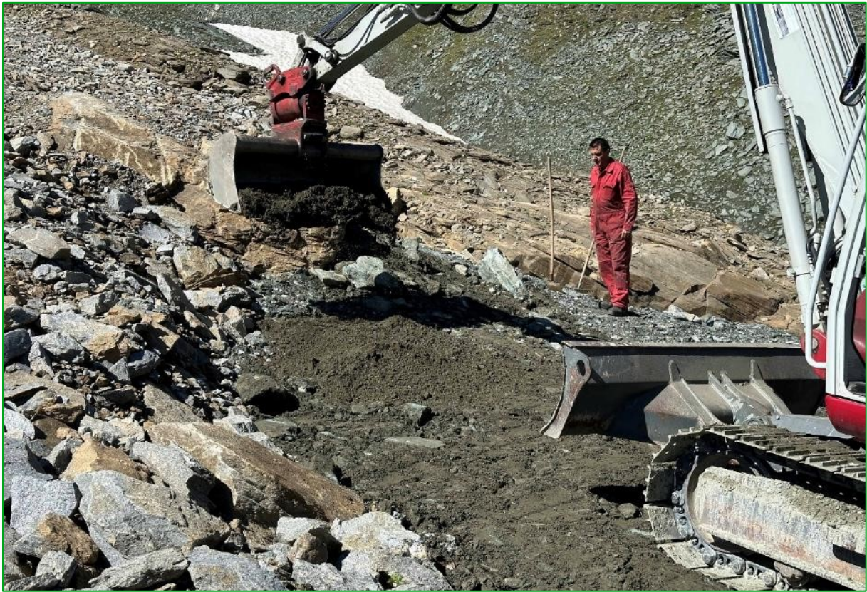
Bild 11: Beginn des Oberbodenauftrages im Bereich der Geländeangepassungen bei der Rettenwandkompression (06.08.2024).
