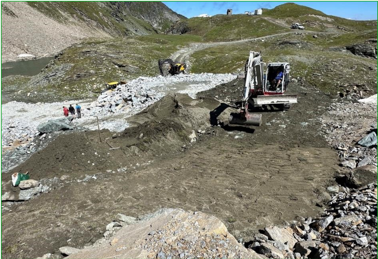
Bild 15: Sukzessives, rückschreitendes Arbeiten des Baggers im Bereich der Begrünungsflächen (06.08.2024).
