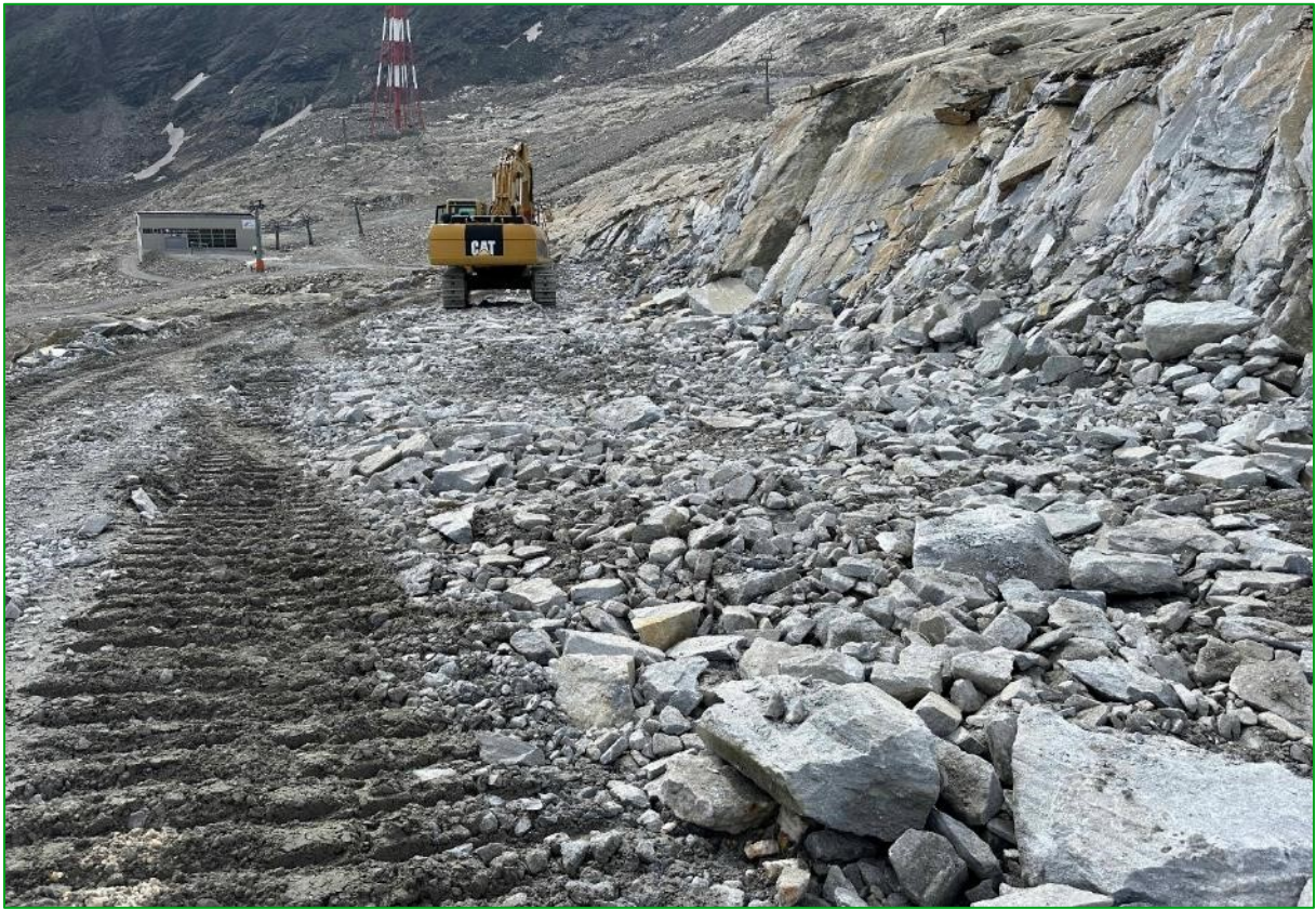
Bild 31: Diese verbreiterten Pistenflächen sind noch im Jahr 2025 durch Einbau möglichst großer, braun gefärbter Felsbrocken heterogen und naturnah zu gestalten (22.08.2024).
