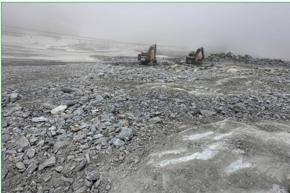
Bild 28: Durch heterogene Schüttungen mit unterschiedlichen Korngrößen und durch gute Einbindung der vom Gletscher vorgegebenen Felslandschaft sind die Pistenanpassungen kaum von der Naturlandschaft zu unterscheiden (15.07.2024).
