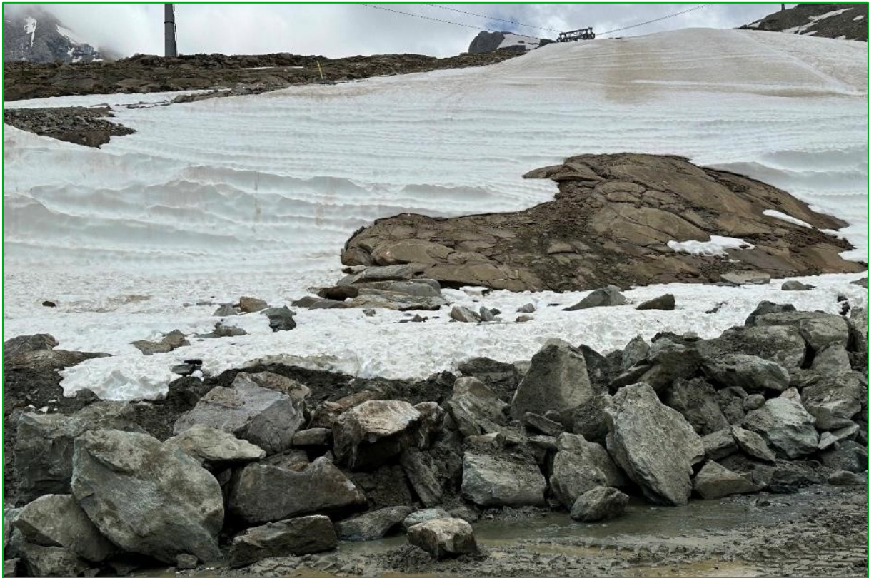
Bild 9: In den nordwestlichen Abschnitten des Gestaltungsareals der Kompression der Rettenwandpiste wurde Schnee geräumt und es wurden bereits in den vegetationslosen Flächen erste Schüttungen (große Steine) durchgeführt (27.06.2024).
