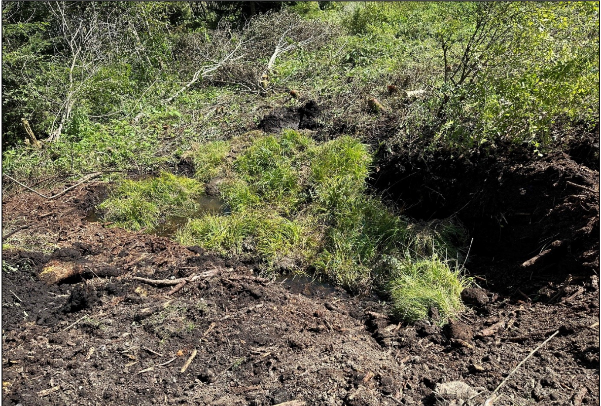
Bild 25: Die Rasensoden mit Feuchtvegetation wurden in einer gut wasserversorgten vegetationslosen Fläche südwestlich oberhalb der Liftbaustelle zwischengelagert (6.9.2023)
