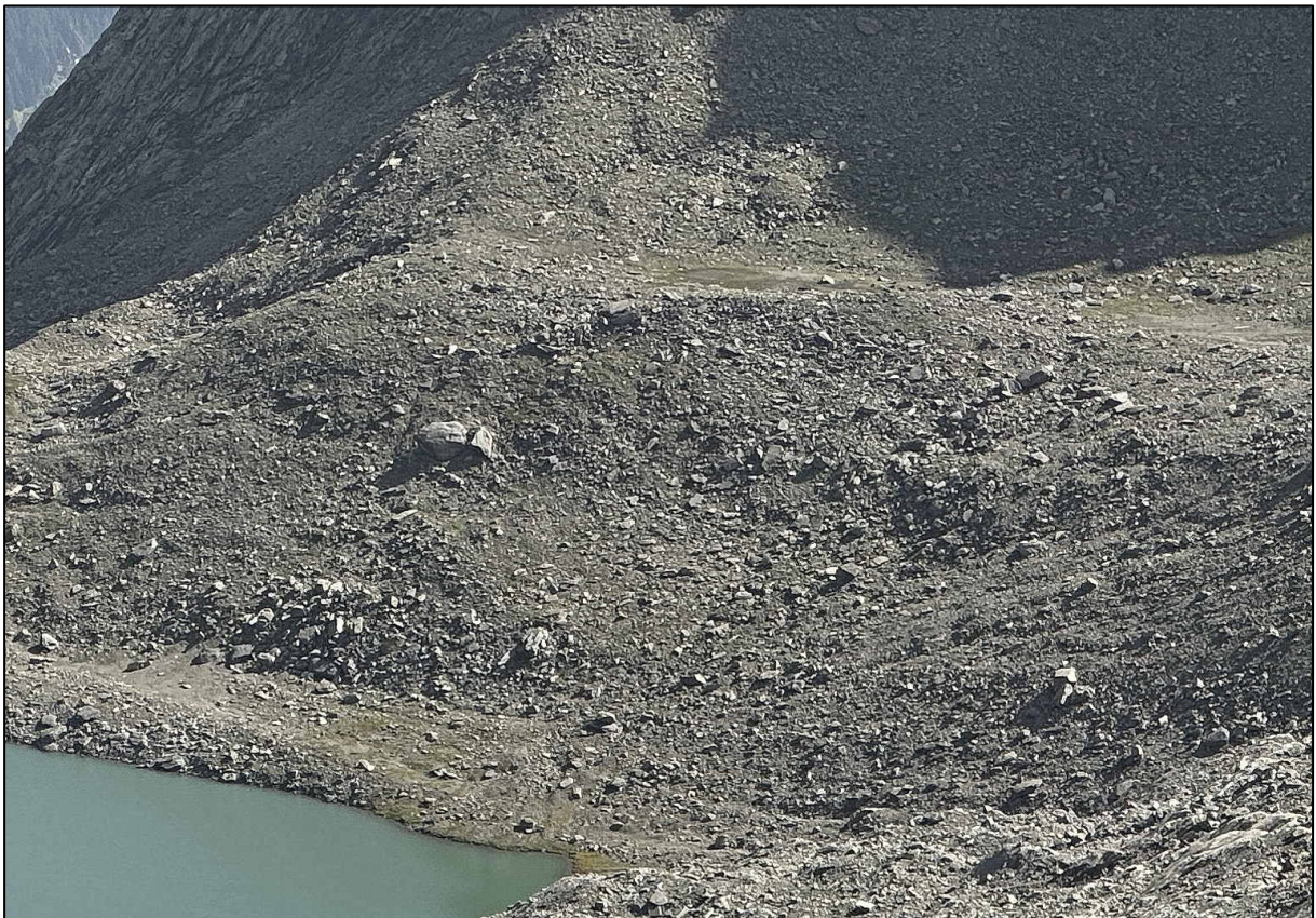
Bild 18: Anthropogen unberührtes Gletschervorfeld als Gestaltungsvorgabe für die geländeändernden Maßnahmen im Bereich des Gletscherschigebiets bzw. der durch Gletscherschwund notwendigen Geländeanpassungen (24.8.2023).
