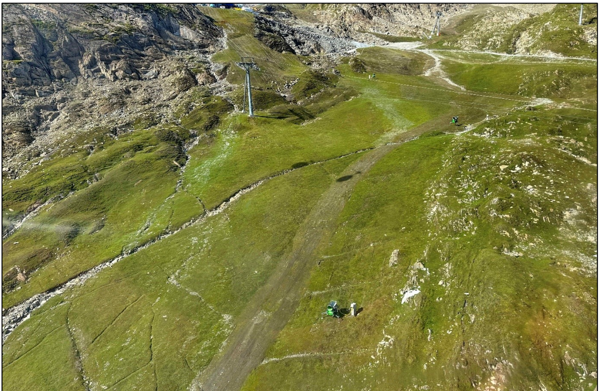
Bild 2: Auch die Begrünungen der Pistenflächen unterhalb vom Alpincenter in einer Höhenlage zwischen 2.300 und 2.400 m sind erosionsstabil und gut gefestigt (24.08.2023).
