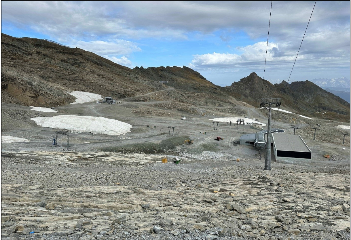
Bild 9: Vor Einsetzen der Wintersaison wurden die Baustellen geräumt und das Gletscherschigebiet ordnungsgemäß gesäubert (10.10.2023).
