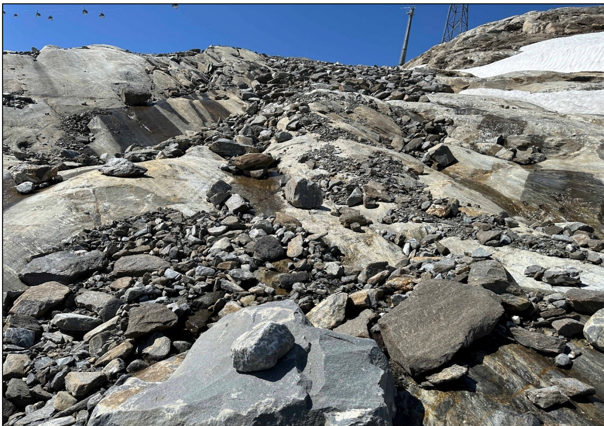
Bild 11: Dort, wo im felsigen Gelände Verlegungen erfolgen müssen, werden schuttgeprägte Teilflächen ausgewählt (18.07.2023).
