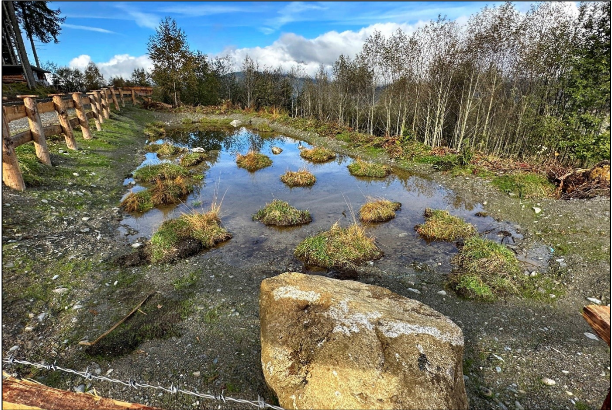
Bild 29: Die geborgene und zwischengelagerte Feuchtvegetation aus den Eingriffsflächen für den Maislift wurde in die Flachwasserzonen eines neu angelegten Gewässers eingebracht und so dauerhaft gesichert (25.10.2023).
