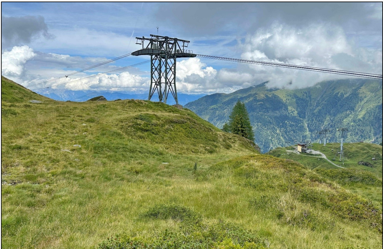
Bild 4: Die Bauarbeiten im Umfeld dieser Stütze nahe beim Langwiedboden sowie auch die in diesem Bereich ehemals verlaufende Zufahrtsstraße sind heute im Gelände nicht mehr erkennbar (31.08.2023).
