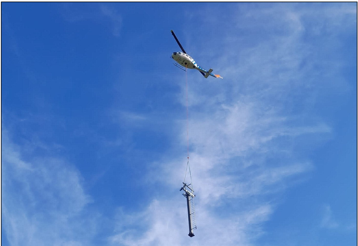
Bild 26: Zur Schonung der Vegetationsdecke und insbesondere der Feuchtvegetation erfolgte der Antransport der Liftstützen mittels Hubschrauber (28.09.2023).
