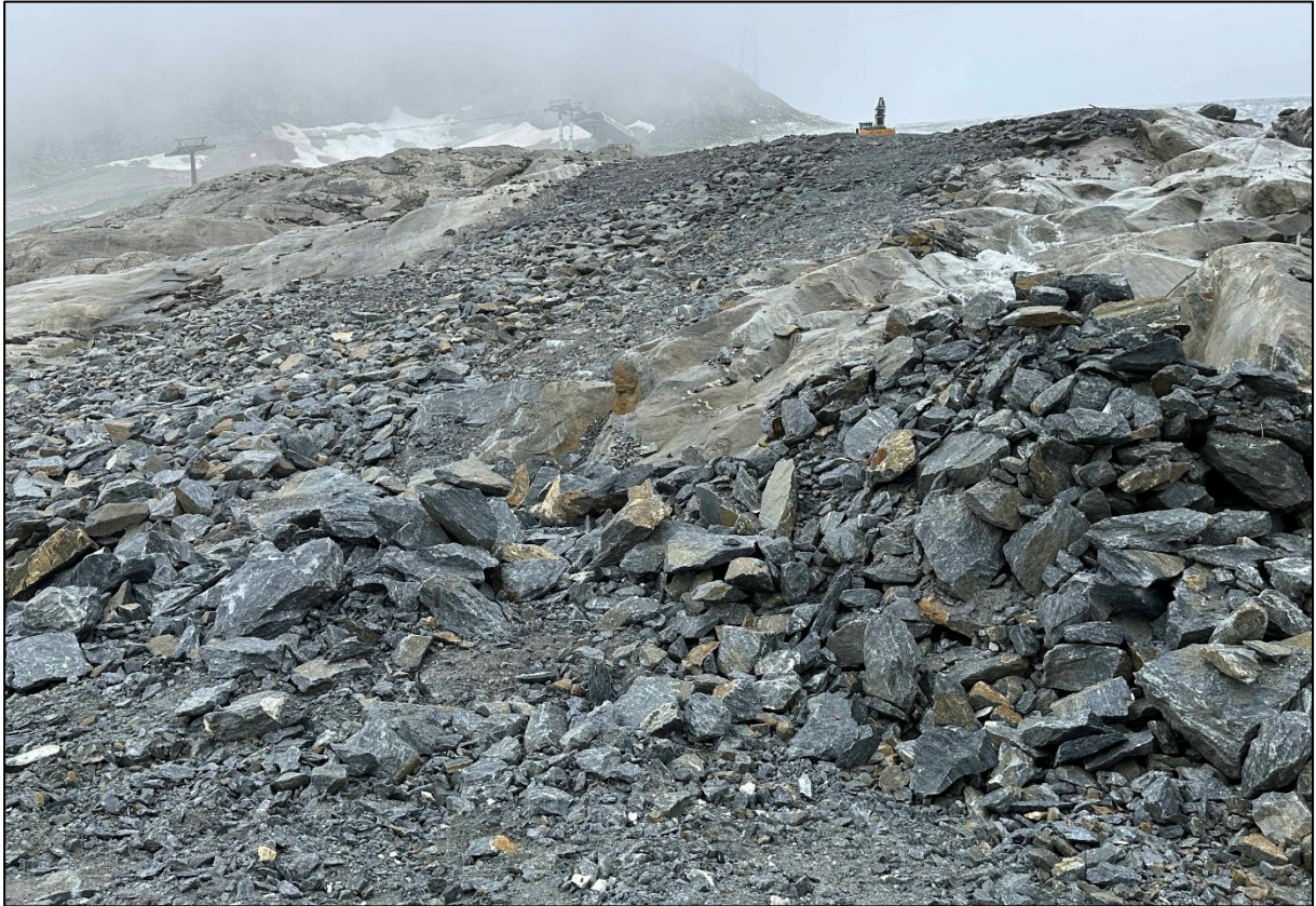
Bild 17: Auch hier wurde die Infrastrukturleitung bereits verlegt; eine gewisse noch heterogenere Ausbildung der Felsschüttungen ist jedoch noch anzustreben (14.09.2023).
