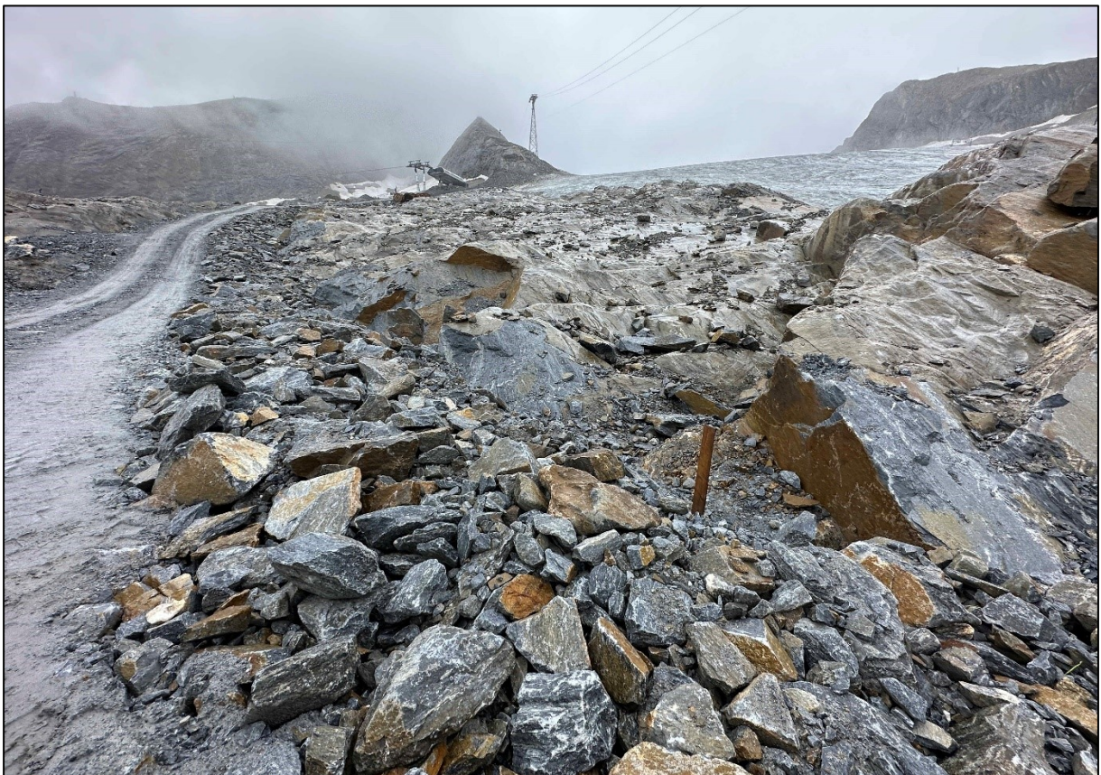
Bild 16: Diese Überschüttung der Infrastrukturleitung bringt bereits eine vergleichsweise gute Integrierung in die Landschaft, die sich jedoch noch in gewissem Ausmaß verbessern lässt (14.09.2023).
