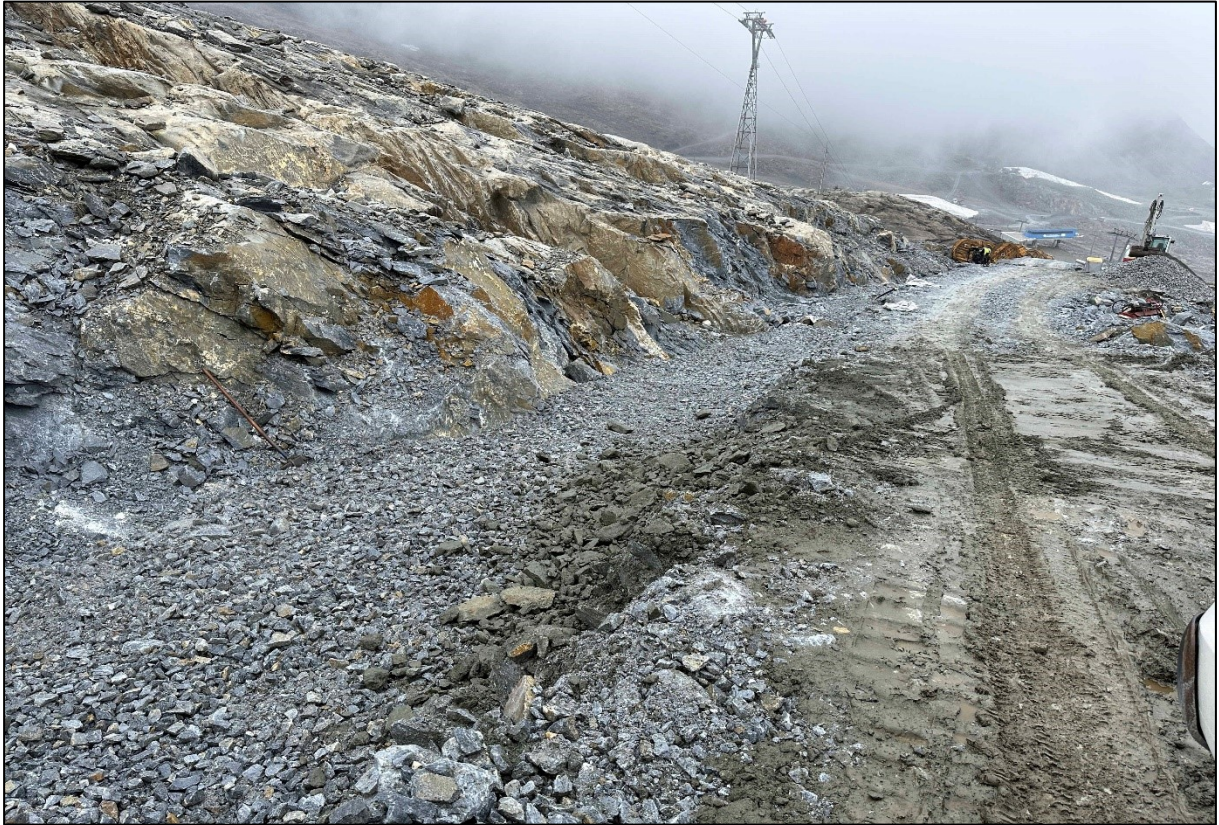
Bild 15: Die Verlegung der Infrastrukturleitungen in den Wegrandbereichen noch ohne erfolgte Gestaltung (14.09.2023).
