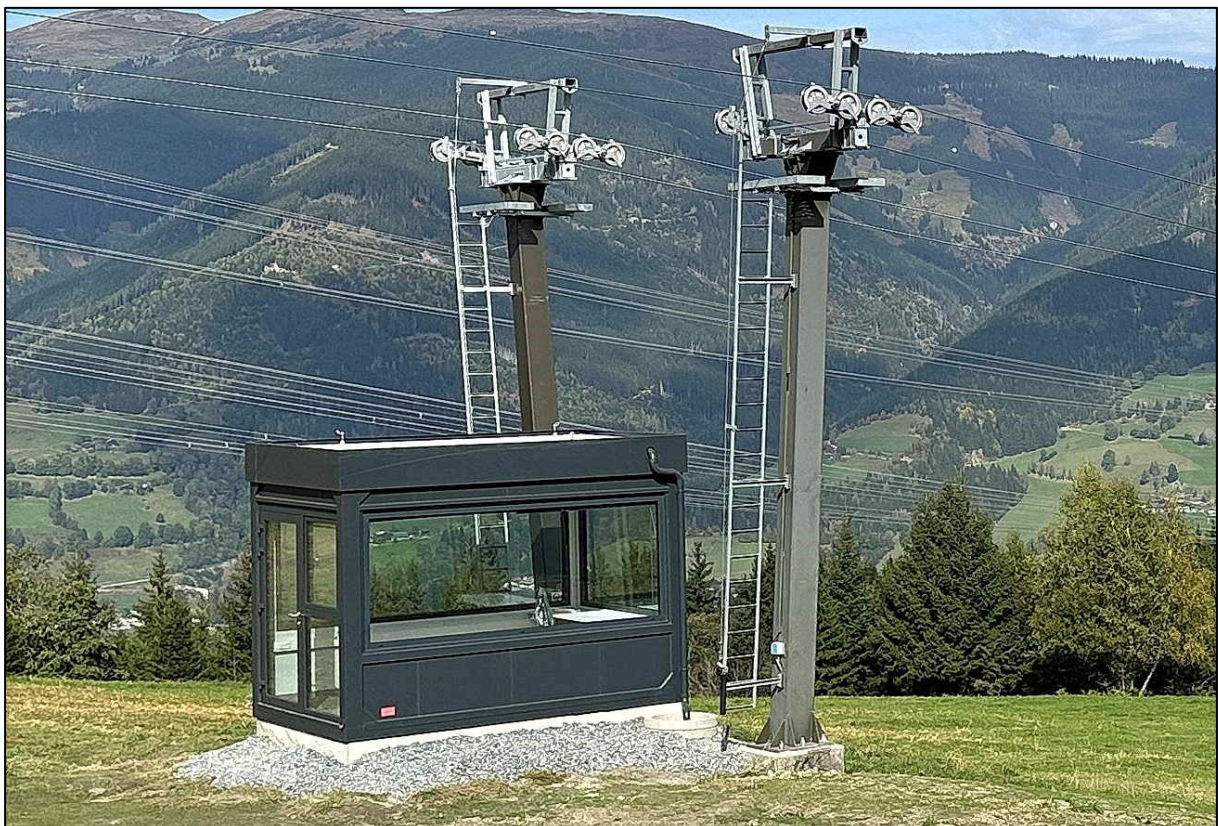
Bild 28: Die Liftstützen und das Liftwärterhaus sind mit Tarnfarben koloriert, die Scheiben des Gebäudes weisen einen Reflexionsgrad auf, der das Anprallen von Vögeln weitestgehend verhindert (10.10.2023).
