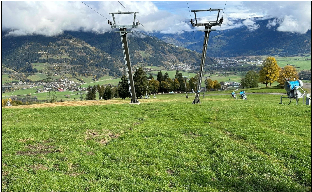
Bild 27: Auch in den intensiver genutzten Wiesenbereichen wurde durch Abheben der Vegetation, randliche Zwischenlagerung und Wiederandocken der geborgenen Rasensoden unmittelbar nach Verlegung der Steuerleitung der ursprüngliche Zustand wieder hergestellt (25.10.2023).
