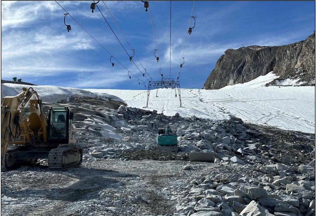
Bild 19: Spreng- und Schremmarbeiten zur Erhaltung der Nutzbarkeit der Schlepplasse der Kitzlifte (28.09.2023).
