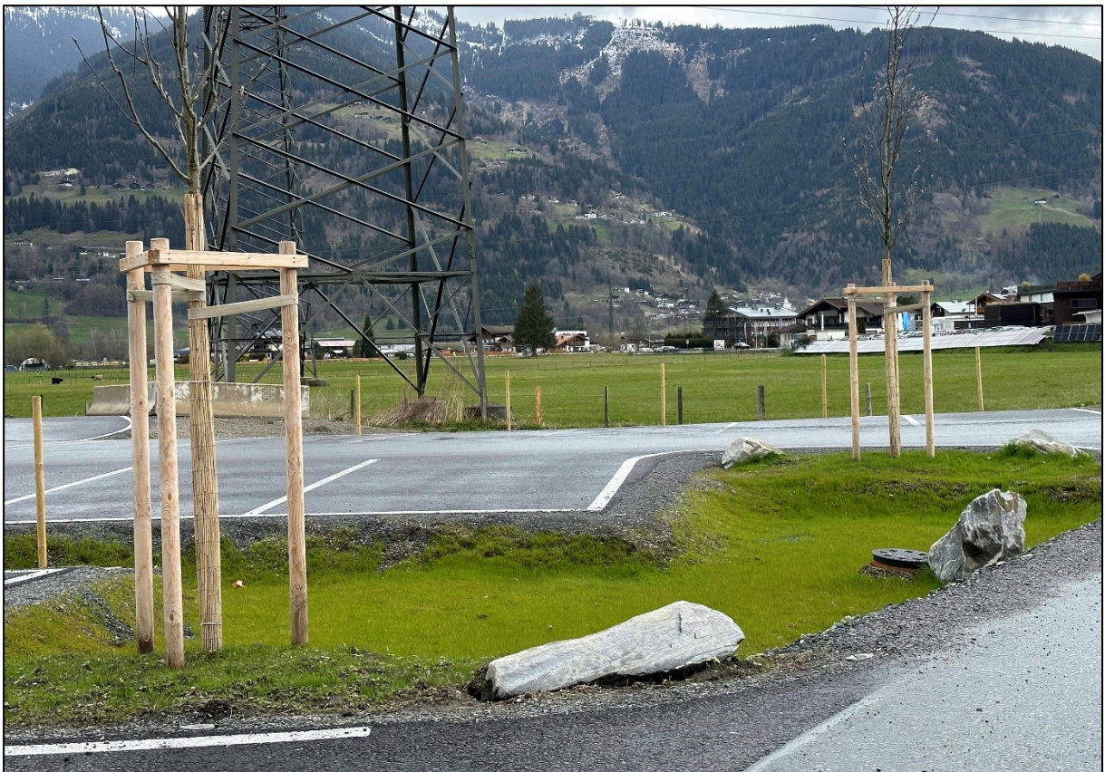
Bild 30: Die Sickermulden am Parkplatz Maiskogel sind ordnungsgemäß begrünt und damit gut funktionell (19.04.2023).
