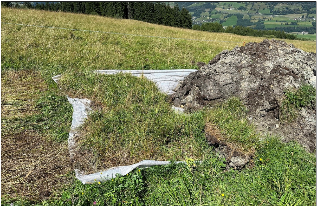
Bild 24: In jenen Bereichen, in denen beim Bau des Maisliftes II in Feuchtvegetation eingegriffen wird, wurde diese vorerst auf einem Bauvlies gelagert (26.8.2023).
