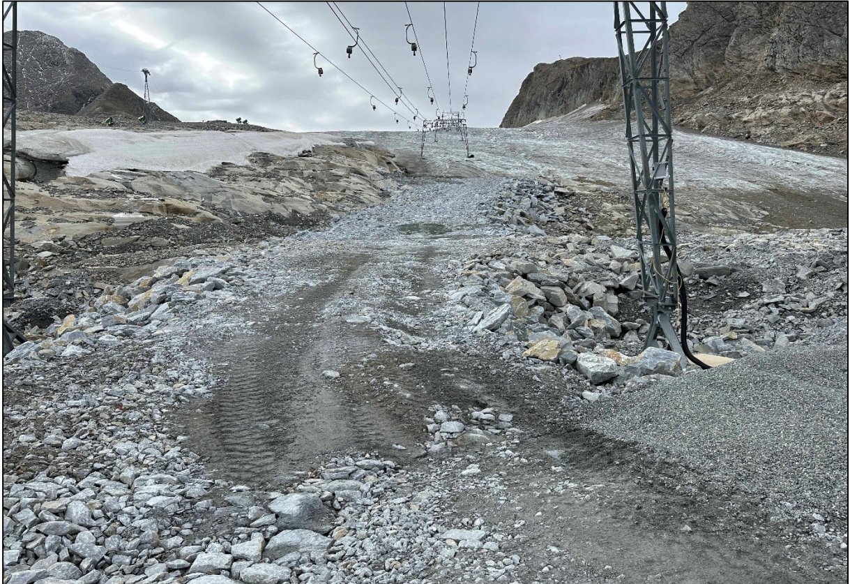
Bild 21: Diese Geländegestaltung geht zwar schon in die richtige Richtung, ist jedoch noch durch harmonischere Übergänge ins Umfeld und durch eine entsprechende Gestaltung mit unterschiedlichen Gesteinsfraktionen im Schlepptrassenbereich zu optimieren (10.10.2023).
