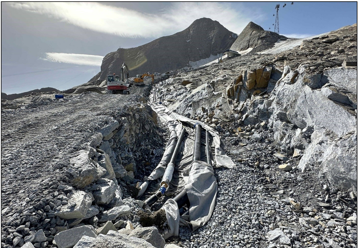
Bild 10: Die Verlegung der Infrastrukturleitung erfolgte größtmöglich in bestehenden Weganlagen oder in Wegrandbereichen (24.8.2023)
